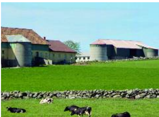
Reparerad silo för förvaring av ensilage
