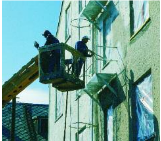
Målning och skydd av fasad
