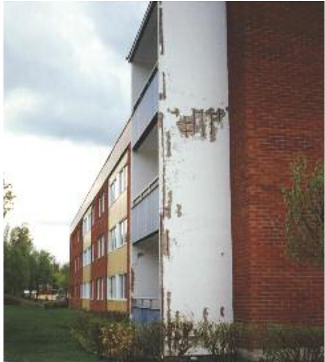
Korroderad armering
