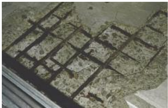
Korroderad armering
