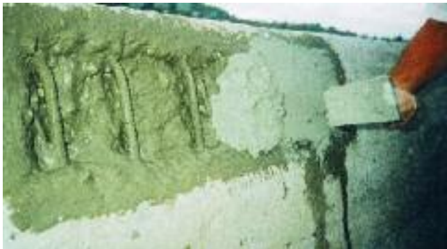
Handapplicering med tixotropiskt reparationsbruk som inte kräver form
