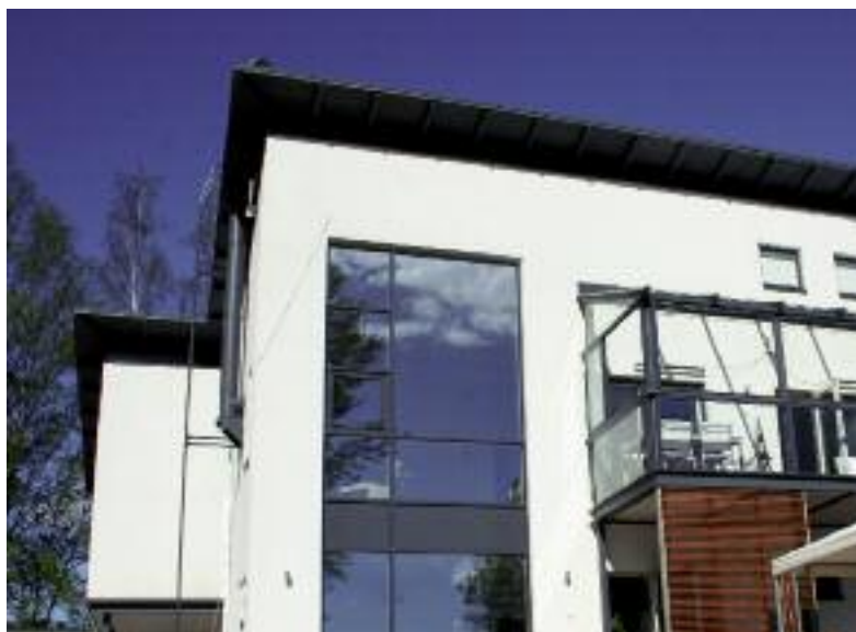
På våren ställer den starkt lysande vårsolen och den kalla nattfrostens hårda krav på reglering av inomhustemperaturen.
