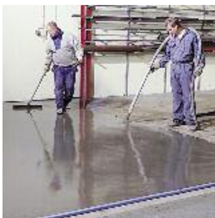
Beläggningen påförs och jämnas av.
