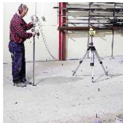
För att ytan ska bli absolut plan mäts nivåskillnaderna upp och markeras.
